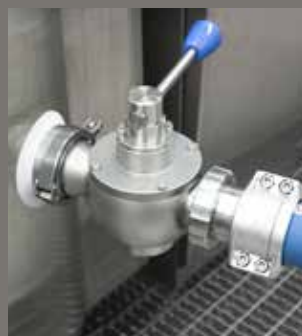
Клапан автомат. рециркуляции CIP D2 SMS63 TC/SMS51
