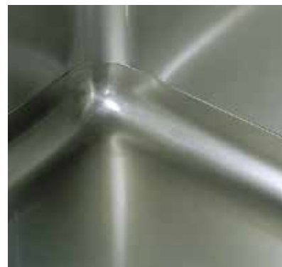
Внутренние углы закруглены для облегчения чистки и, как следствие, для повышения уровня гигиены.
