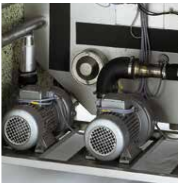
Система с двумя насосами и режим вращения экономит электроэнергию, воду, гранулы, моющее средство и средство для ополаскивания.
