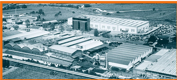
San Bonifacio (Italy) котлы
