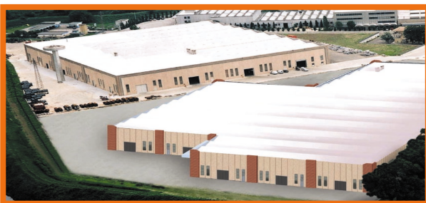
Villanova di San Bonifacio (Italy) промышленные котлы чиллера
