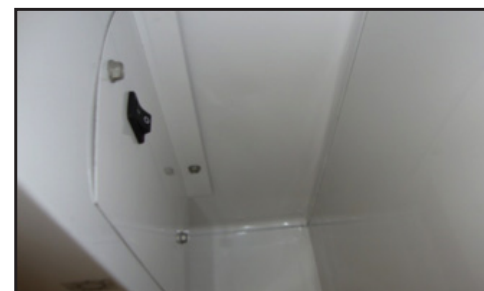
Лампы шкафов с непрозрачными дверями управляются выключателем на двери.
