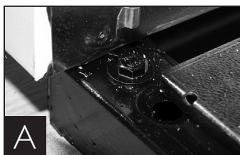
Демонтаж транспортировочной подставки с днища шкафа.
