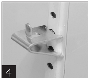
4 (Установка кронштейна полки завершена)
