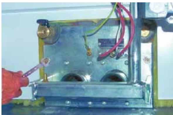
рис. 22 - Демонтаж горелок
